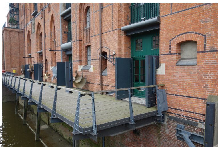
Exemple de mesures de prévention : protection « anti-crues » ouvertes - Musée maritime de Hambourg.
